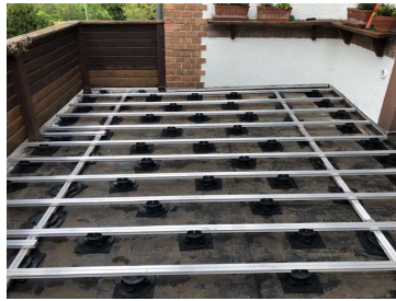
Aussteifung mit Konterlattung
