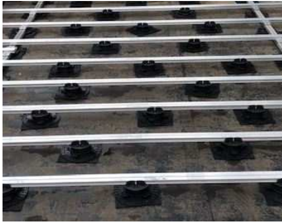
Anordnung der Stellfüße, Beispiel mit Standard- UK für Re-elko Terrassensystem TSK
